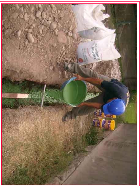
DETALLE DE ZANIA CON VERTIDO DE LIQUIDO MIEORANTE
