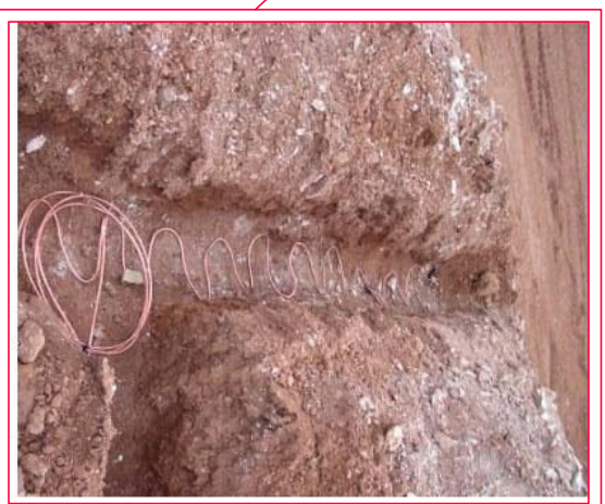
DETALLE DE ZANIA CON HILO DE COBRE DESNUDO
